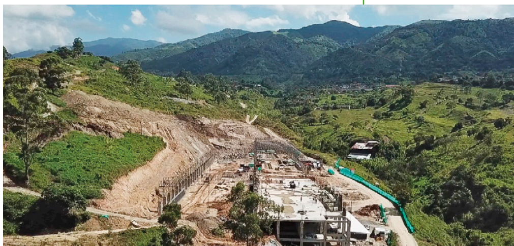
Aerial view of the new brick plant civil works underway Veduta aerea della nuova fornace con opere civili in corso
